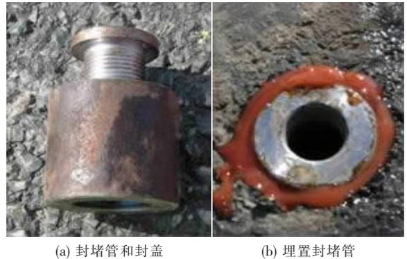
图3 砂浆灌缝工艺
