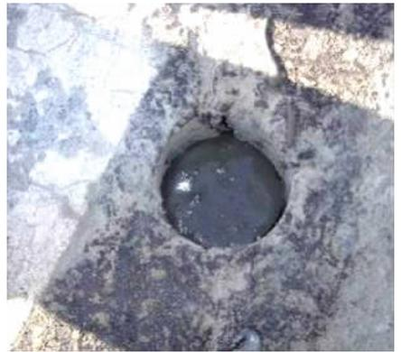
图4 相邻孔洞中的砂浆
