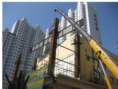
图 11 主框架梁内置 H 型钢的吊装
