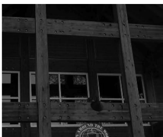
图1 销式连接节点
