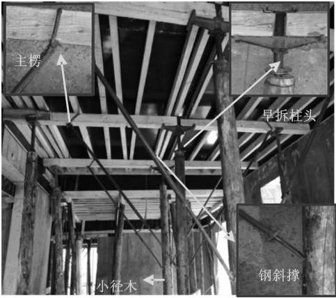
图 1 钢木组合早拆体系构造 (mm)
