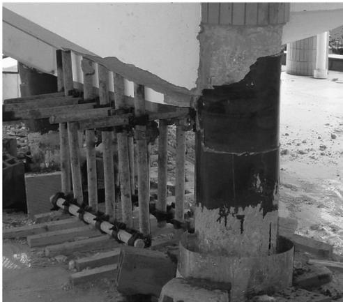
图 10 加固后的压溃柱
