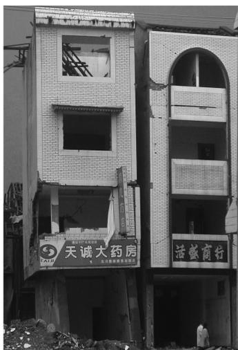
图 6 单跨框架结构强梁弱柱破坏
