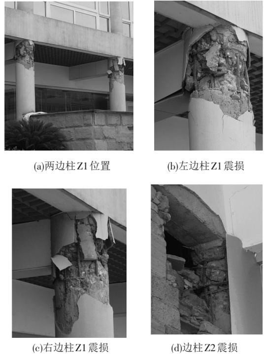
图 5 某展览馆钢筋混凝土圆柱震损情况
