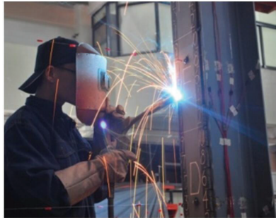
(b) 加固焊接施工
