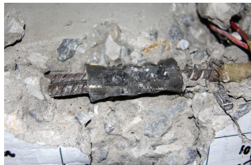
(b) 钢筋套筒挤压搭接接头
