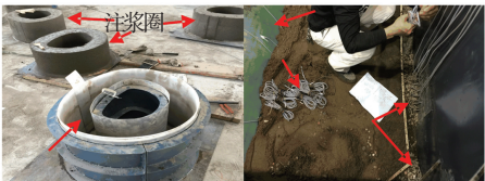
(a) 注浆圈制作 (b) 铺设围岩及水压力计
