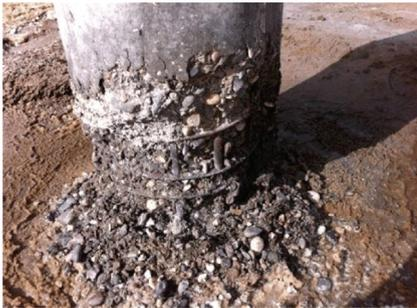
图 2 盐碱地电杆混凝土腐蚀脱落
