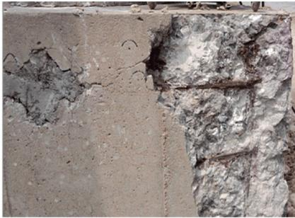
图 1 近海环境基础锈胀开裂
