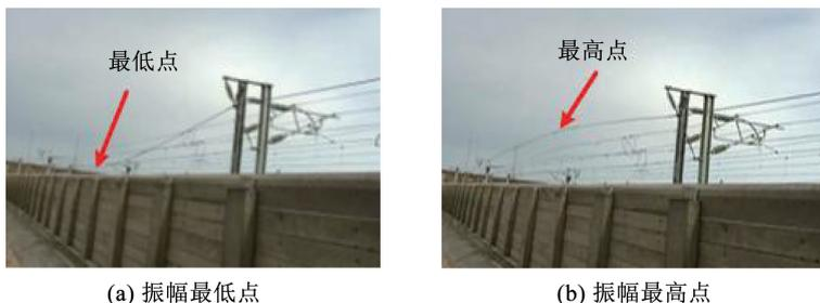
图 1 大风区段兰新高铁接触网附加导线舞动
