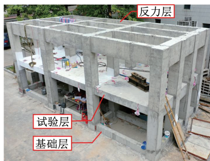
(a) 试验结构现场
