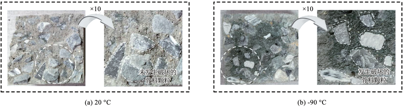
图 4 不同温度下劈拉破坏面及局部破坏细节 Fig. 4 Local fracture details undersplitting tensile failure at different temperatures
