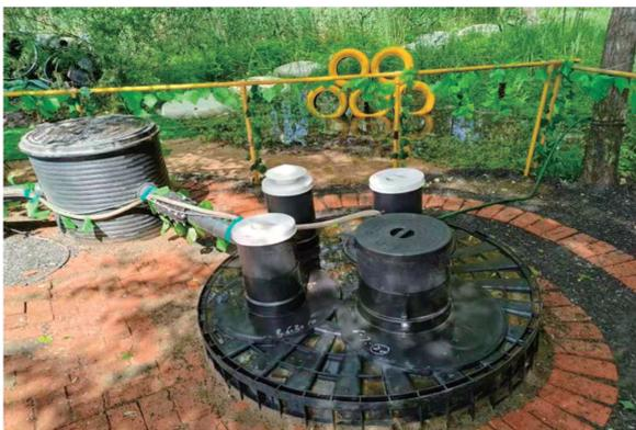
(c) 净化槽水冲厕系统实物图
