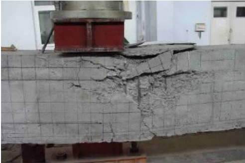
图 6 梁 L-3 跨中混凝土压碎区
