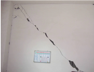
图 2 斜裂缝
