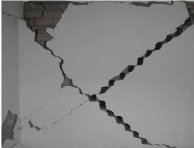
图 3 X 型裂缝
