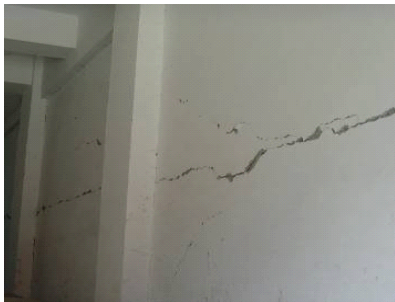
图 1 水平裂缝
