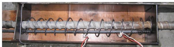
图 3 波纹管、预埋钢筋和螺旋筋放入钢模中
