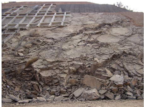
图 4 K115 + 350 ~ 390 段左侧滑坡
