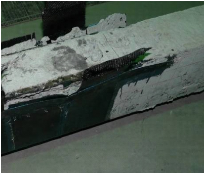
图 6 加固 II 型试验梁破坏形态
