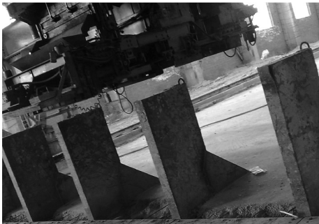
图 10 台面面层铺设前的张拉台座支架
