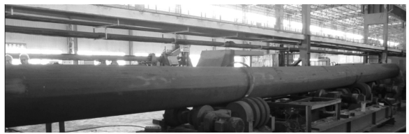
图 3 待矫大型直缝焊管测量现场
