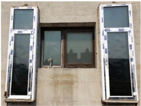
图 1 新型太阳墙墙体外观实物
