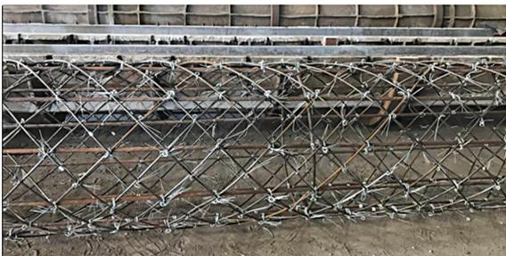
图 1 新型网状箍筋
