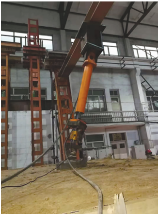
图 7 现场实际加载
