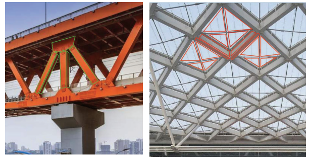
(a) 桥梁钢梁外表面
