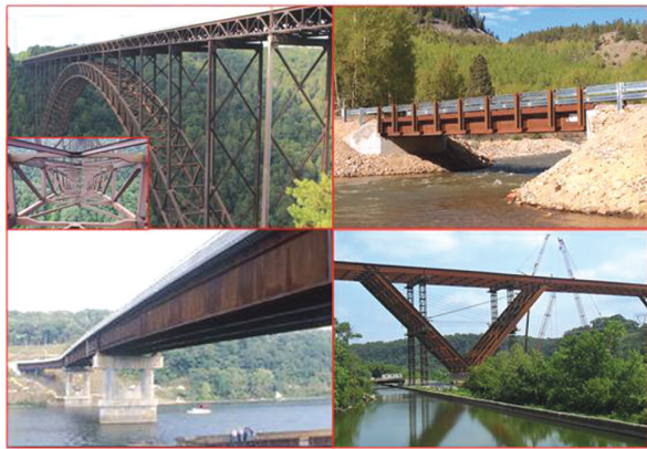
图 5 部分美国免涂装耐候钢桥梁照片
