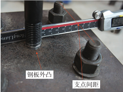
(a) 试验组合螺栓钢板外凸
