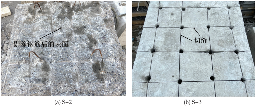
图 3 混凝土厚板处理后实物
