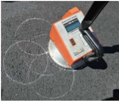
图 2 压实度检测 Fig.2 Compaction degree test
