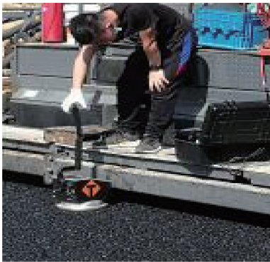
图 5 采用无核密度仪检测混合料的摊铺压实度
