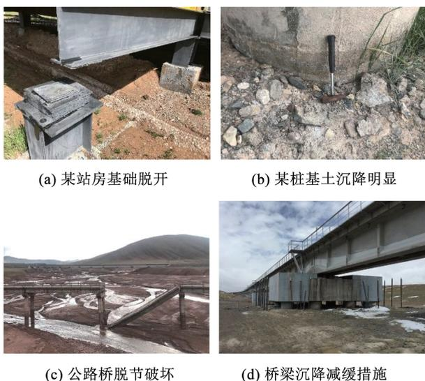
图 1 青藏高原桩基础劣化
